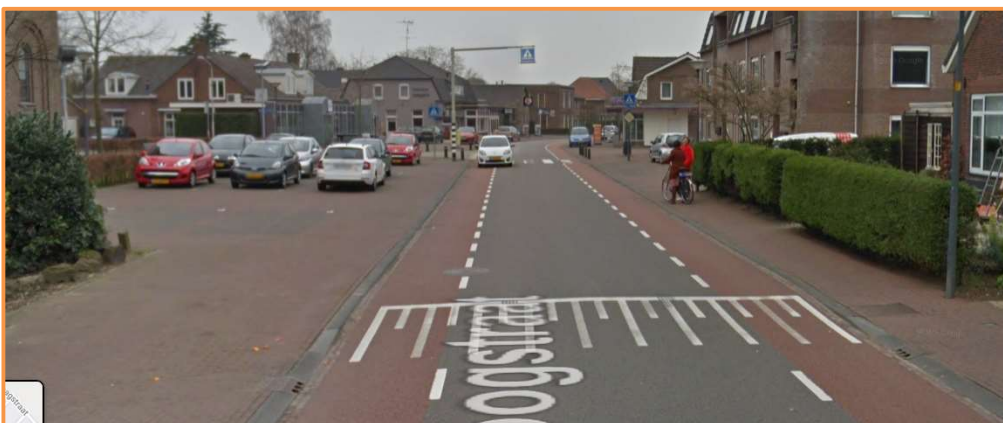
Fig. 9. Langgerekte plateau's in de Hoogstraat (N846) door Overasselt. De maatregelen zorgen voor enige demping van de gereden snelheid. Deze maatregel heeft overigens het minste effect op de verkeersveiligheid van alle voorgestelde maatregelen.
