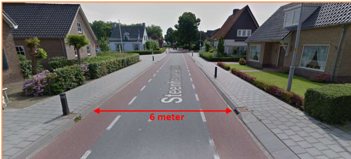
Fig. 1. De Steenheuvelsestraat in Leuth, met aan weerszijden rode suggestiestroken. De paaltjes zijn geplaatst om te voorkomen dat over het trottoir gereden wordt.
