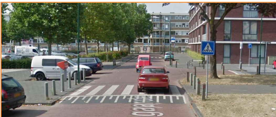
Fig. 10. Voorbeeld van een zebrapad op een plateau. Dit remt een eventueel inhalende auto. Aanvullend kan ook links een bord geplaatst worden, en is extra verlichting zeer gewenst.
