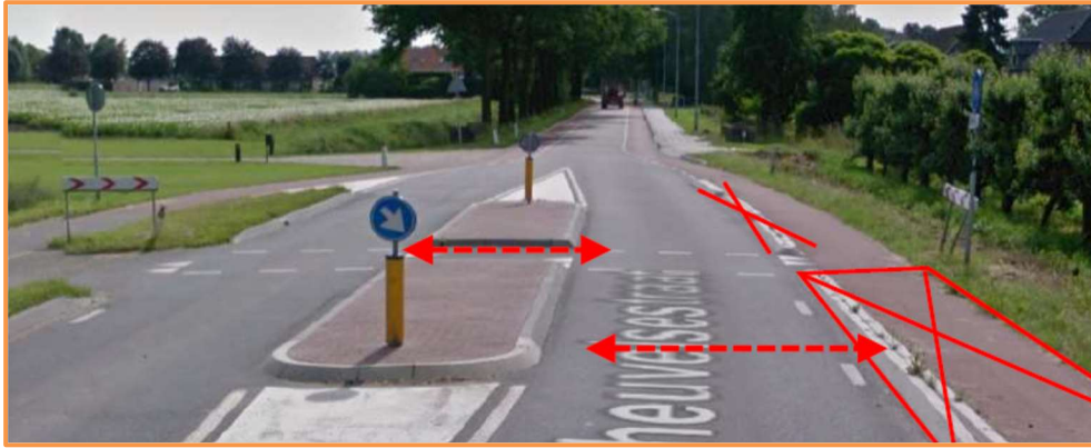
Fig. 13: mogelijke verbeteringen aan de westelijke fietsoversteek: verbreding middeneiland, versmalling rijbaan, verwijdering smalle geleiders en inruilen stuk ongebruikt fietspad voor een strook gras met een band (zoals aan de noordzijde)
